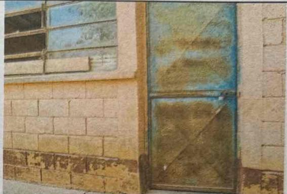
Foto 2: PUERTAS DE METAL: Se evidencia residuos de óxido y deterioro de las puertas.
