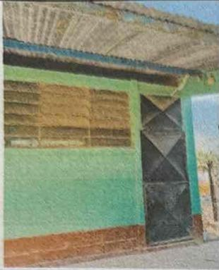
Foto 1: CUBIERTA DE LÁMINA Y ESTRUCTURA: Se observa deterioro del las láminas y de la estructura, presenta signos de oxidación.
