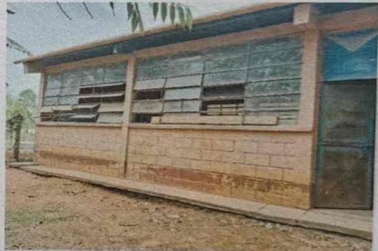
Foto 4: PINTURA INTERIOR Y EXTERIOR: Evidencia el deterioro de la capa de pintura.
