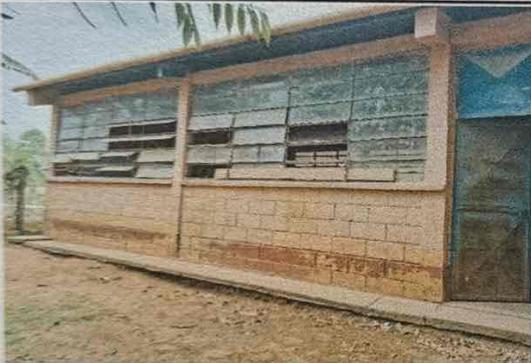
Foto 3: VENTANAS: Se observa el deterioro de las ventanas y falta de balcones.
